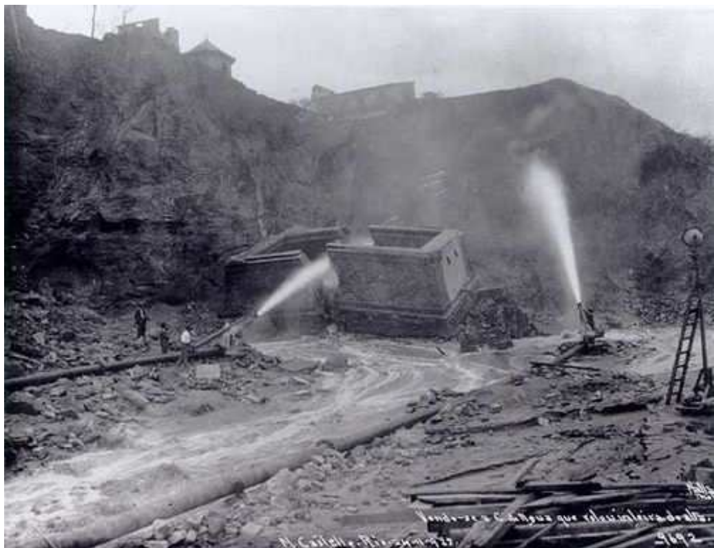
Trabalhadores utilizando jatos de água para demolir o morro.
