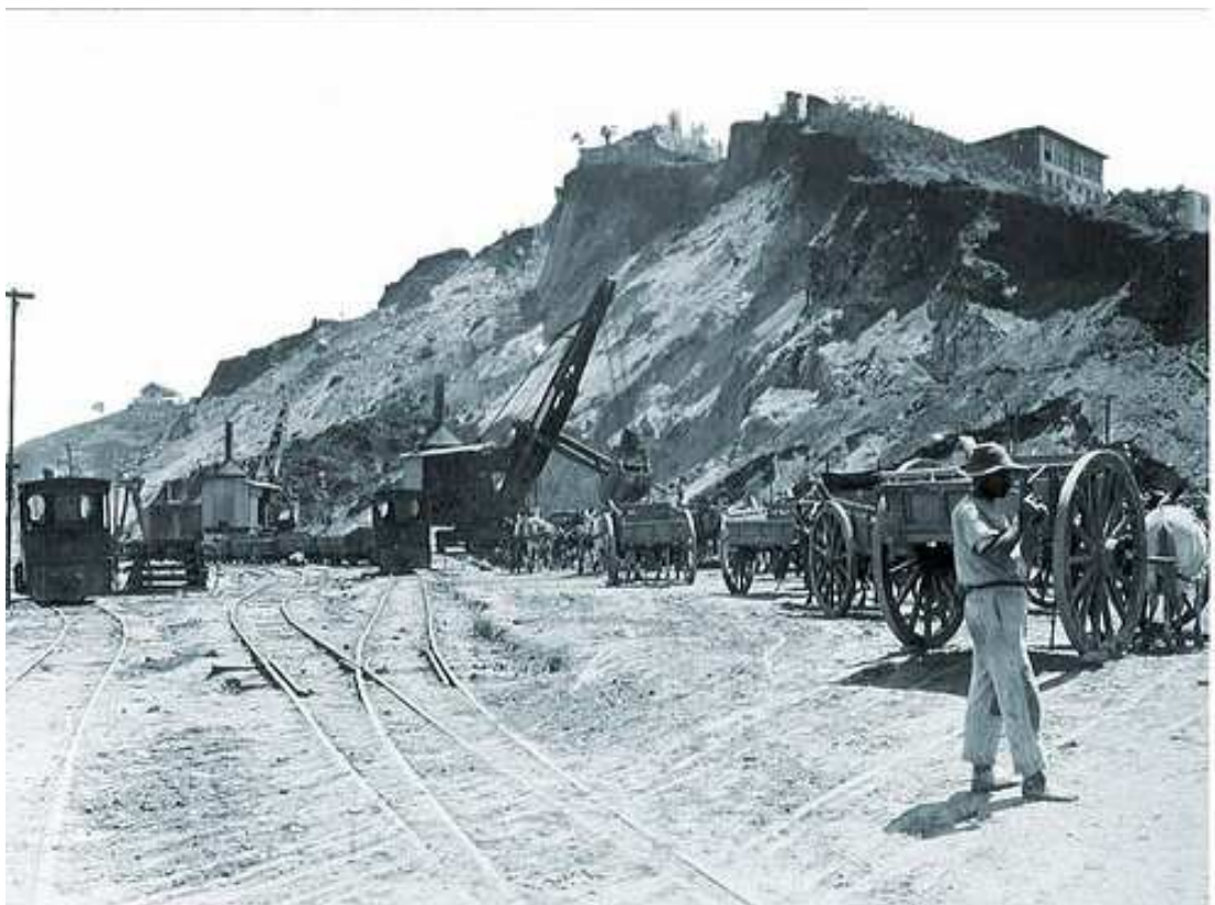
Trabalhadores durante a derrubada do morro do Castelo.
